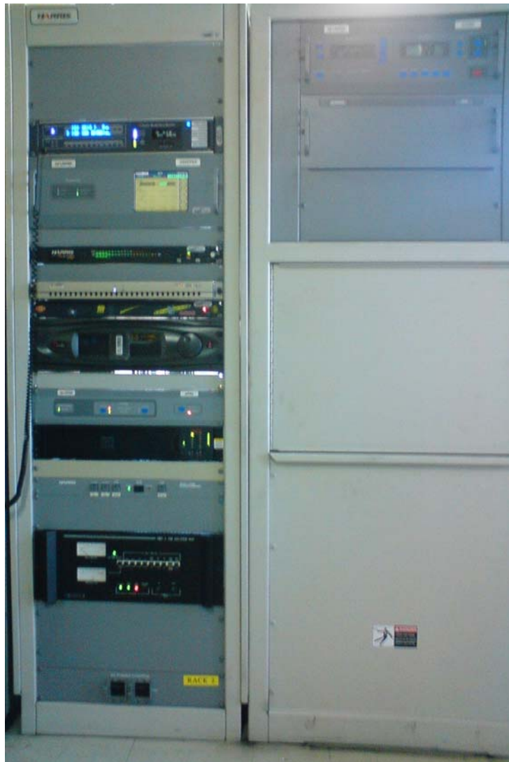
Foto 17 – Transmissores analógico e digital
