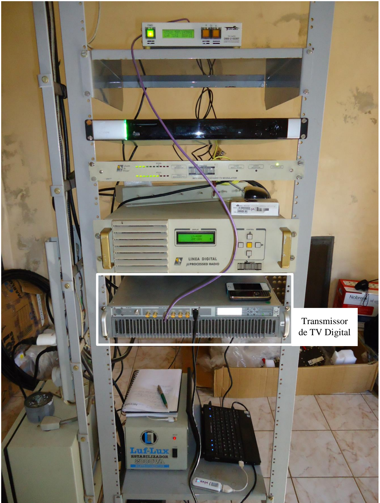
Figura 2. Instalação do transmissor de TVD no Morro do Frota
