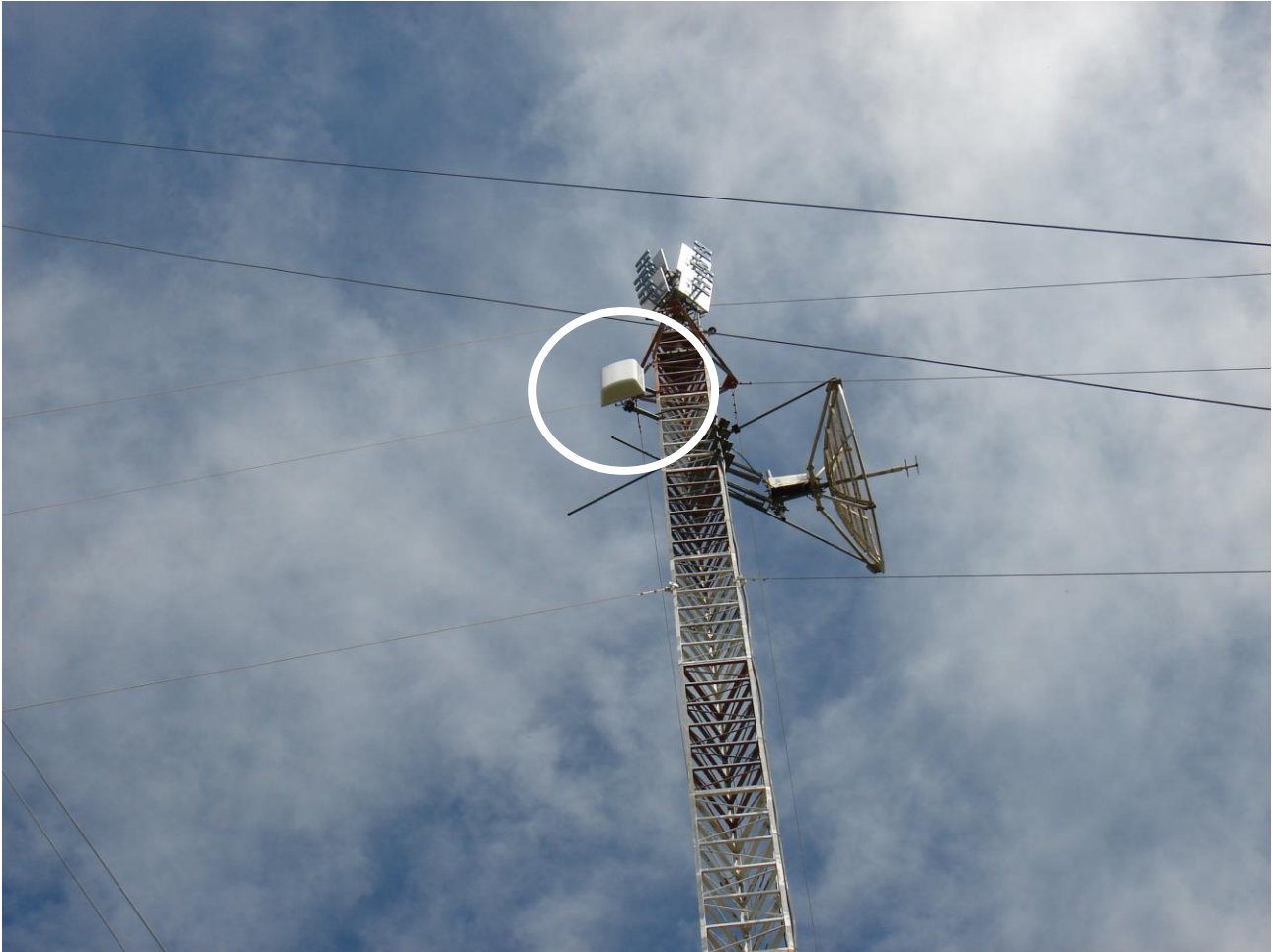
Figura 3. Torre transmissora de TVD. Antena utilizada no detalhe.
